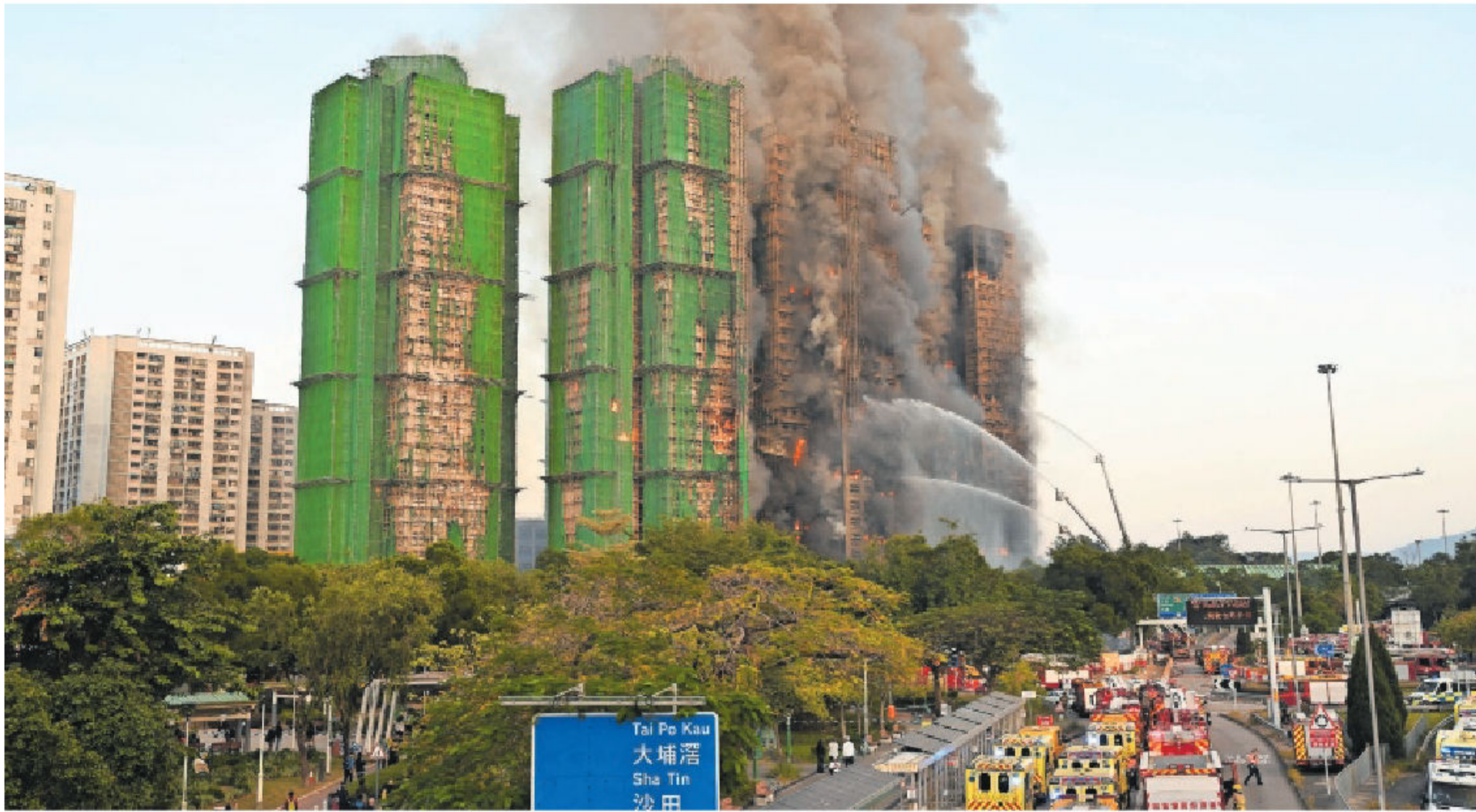
Los bomberos trabajaban ayer para extinguir el incendio del complejo Wang Fuk Court, en el distrito de Tai Po, en Hong Kong. KOBE LI (EP)
